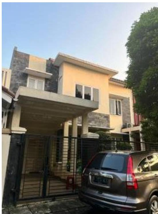
Gambar 7. Perubahan bentuk, atap, bahan bangunan, penambahan ruang car port, dan pagar.
