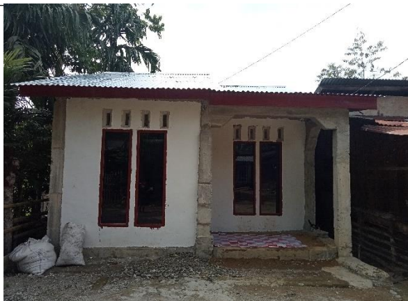
Gambar 5. Fasad rumah progres 100%
