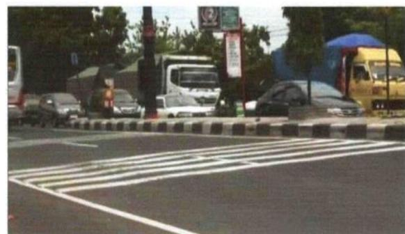
Gambar 3. Pemasangan pita pengaduh (*rumble strips*)
